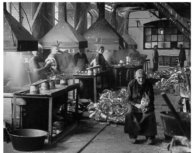
Usine de la casserie à Feschés-le-Châtel
