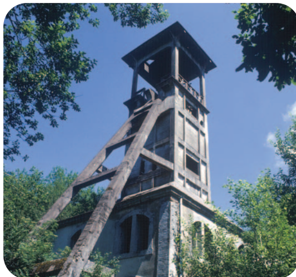
Chevalement du puits de mine Sainte-Marie
